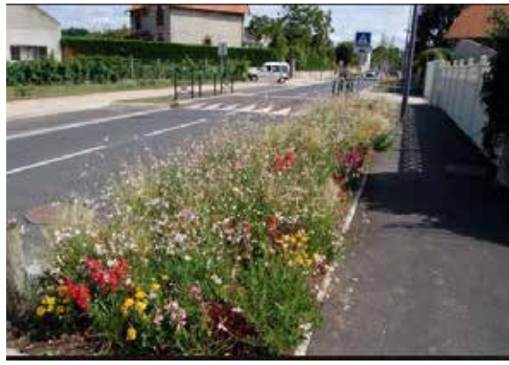
Exemples d'aménagement (source PNR Gâtinais)
