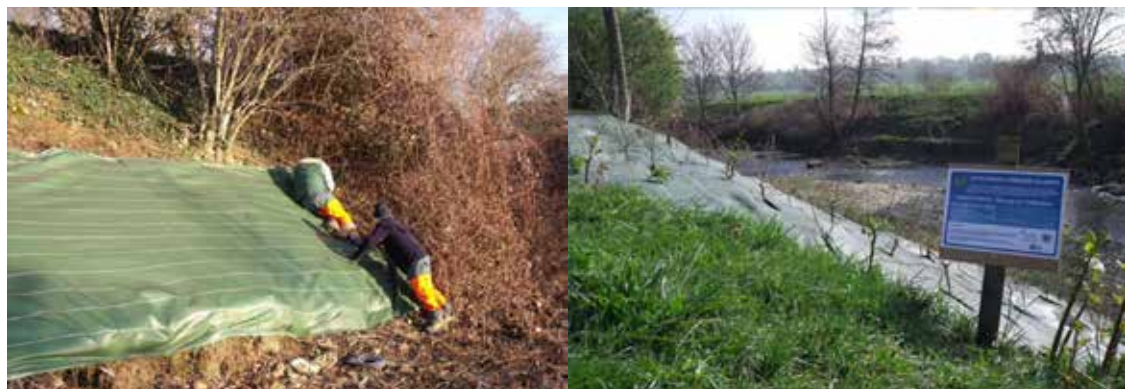
2011 - pose du géotextile et plantation des arbustes (photos SYAGE)
