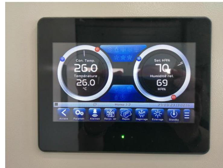
Mini cellules 300kg en conditions régulées en température et hygrométrie
