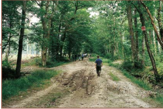
Voirie forestière dégradée
