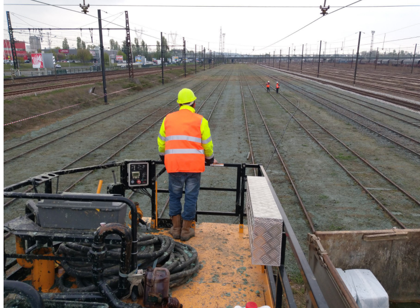
Chantier de Villeneuve-Saint-georges (photo SNCF Réseau)
