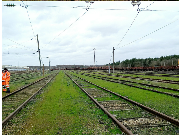
Site d'Achères en juillet 2021 avant implantation (en haut) et en février 2022 (en bas) (photos SNCF Réseau)
