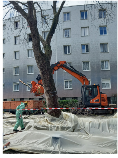
Chantier d'abattage sécurisé à Pantin (93) (photo DRIAAF-SRAL)
