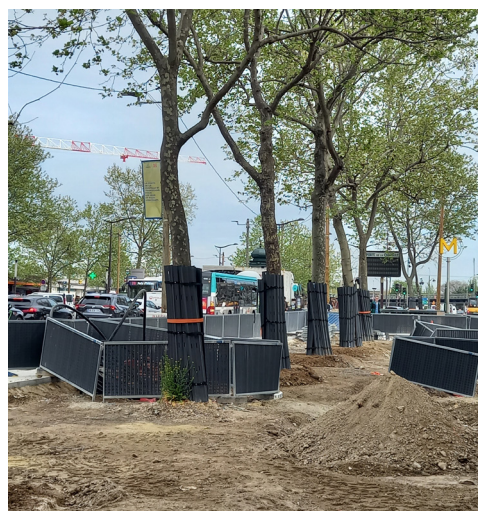
Les platanes parisiens menacés par les nombreux chantiers (photo DRIAAF-SRAL)
